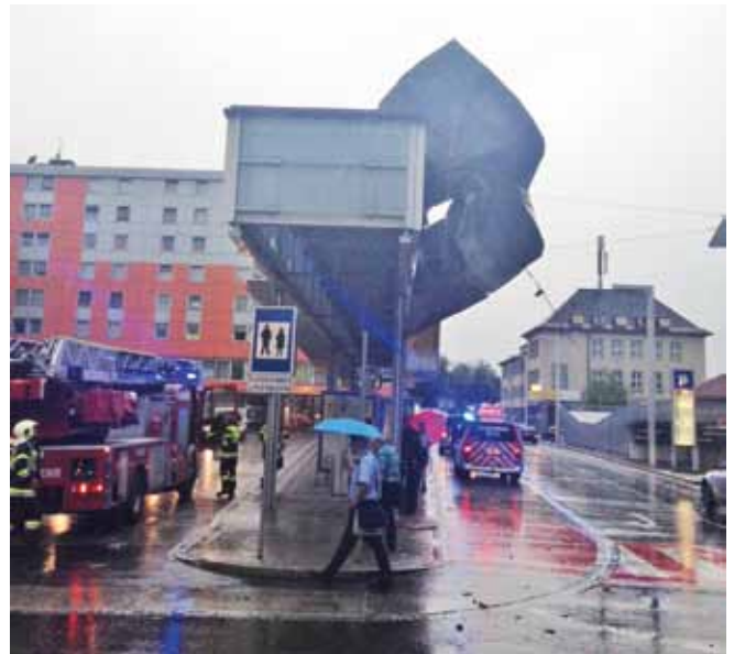
Am Bahnhofplatz riss der orkanartige Sturm ein Blechteil vom Dach und blockierte die Fahrbahn.
