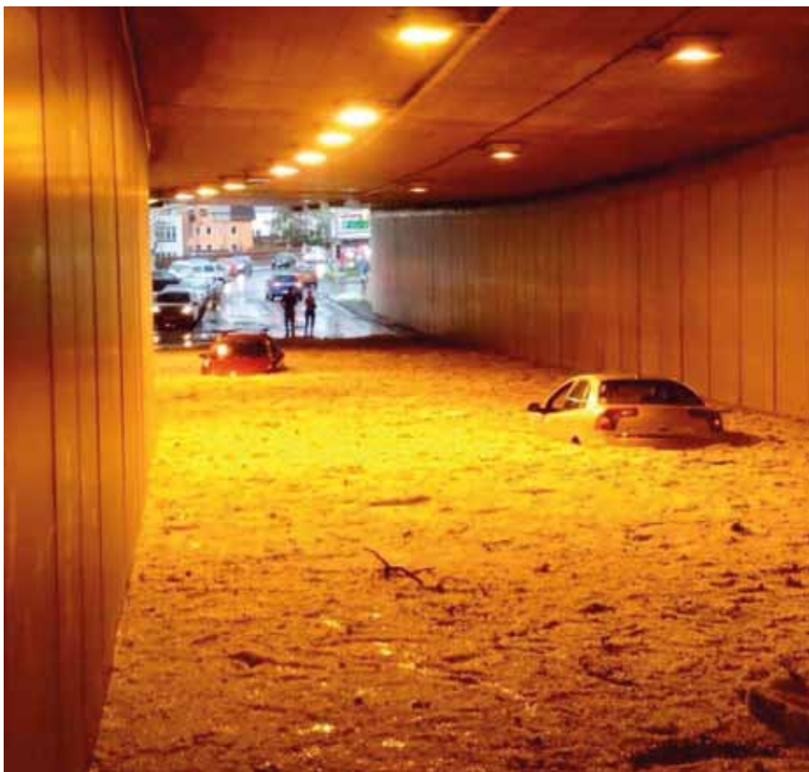
Die enormen Regenmengen und durch den Hagel heruntergeschlagene Blätter von Bäumen wirkten sich fatal auf das Kanalsystem aus. In wenigen Minuten verstopfte diese Mischung die Einläufe der Oberflächenentwässerung – Unterführungen und Straßensenken wurden unpassierbar; einige Fahrzeuge mussten geborgen werden.
