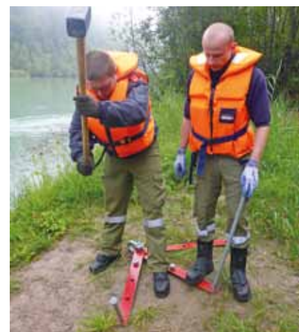
Ein Erdankersatz wird als Anschlagpunkt für die Ölsperren eingeschlagen.
